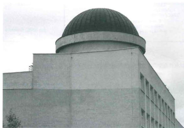
Kopuła planetarium na budynku Instytutu Fizyki AJD
