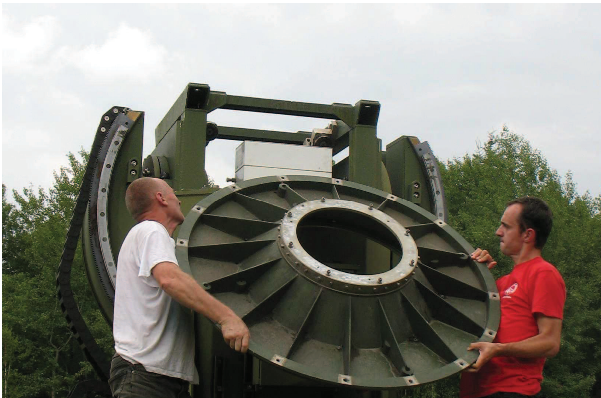
Fot. 9. Pierwsze prace montażowe – autor i Piotr Firlej (z prawej).
