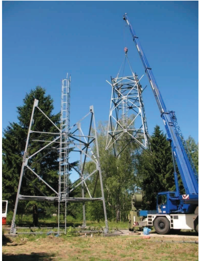
Fot. 5. Demontaż wieży.
