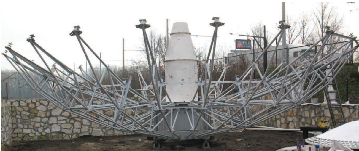
Fot. 9. Rdzeń czaszy z przykręconymi żebrami.
