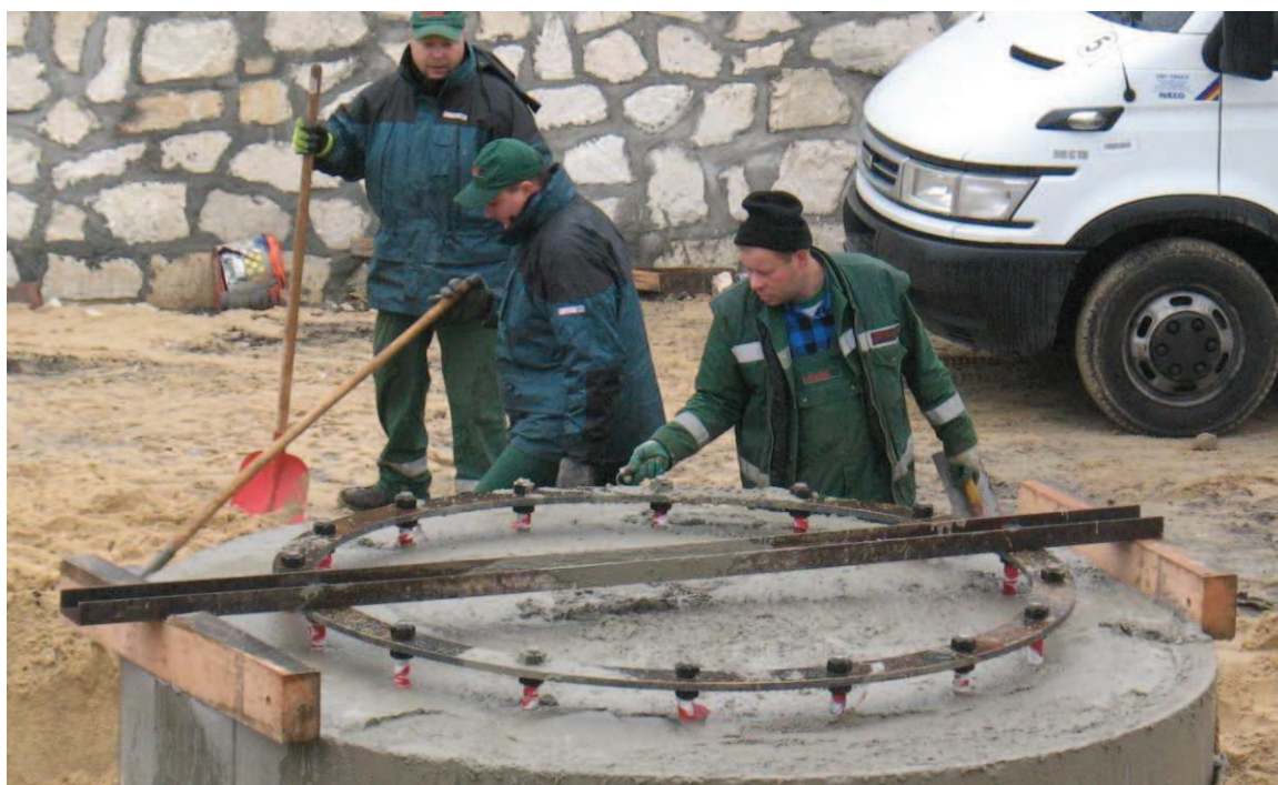
Fot. 7. Prace finalne przy fundamencie.
