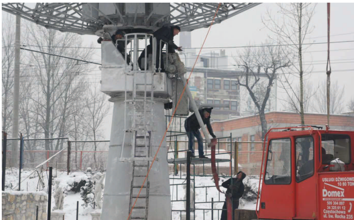
Fot. 22. Finalizacja procesu montowania czaszy.
