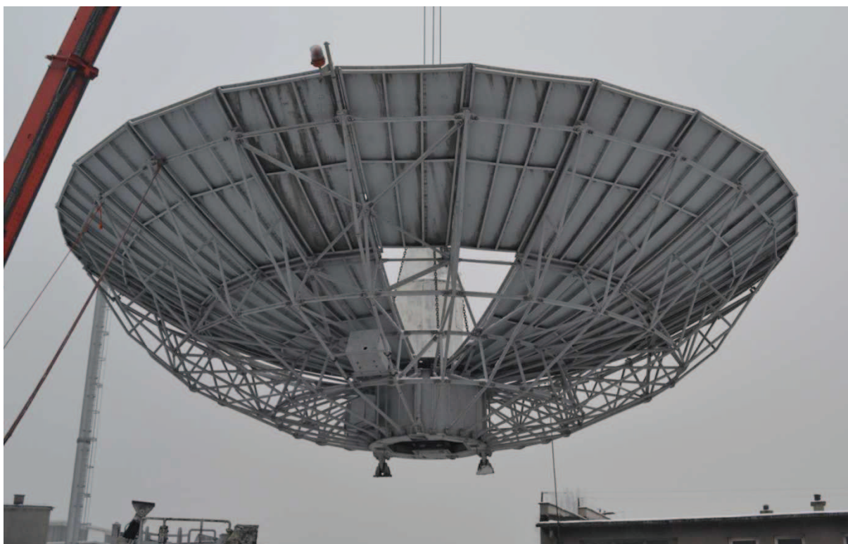
Fot. 20. Czasza powyżej strefy jakichkolwiek zagrożeń zwisa swobodnie na linach dźwigu.
