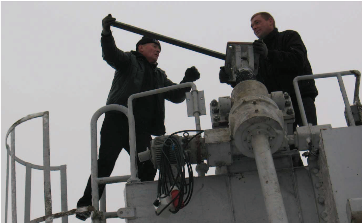
Fot. 17. Prace przygotowujące uchwyty na nodze radioteleskopu do przyjęcia uchwytów czaszy.
