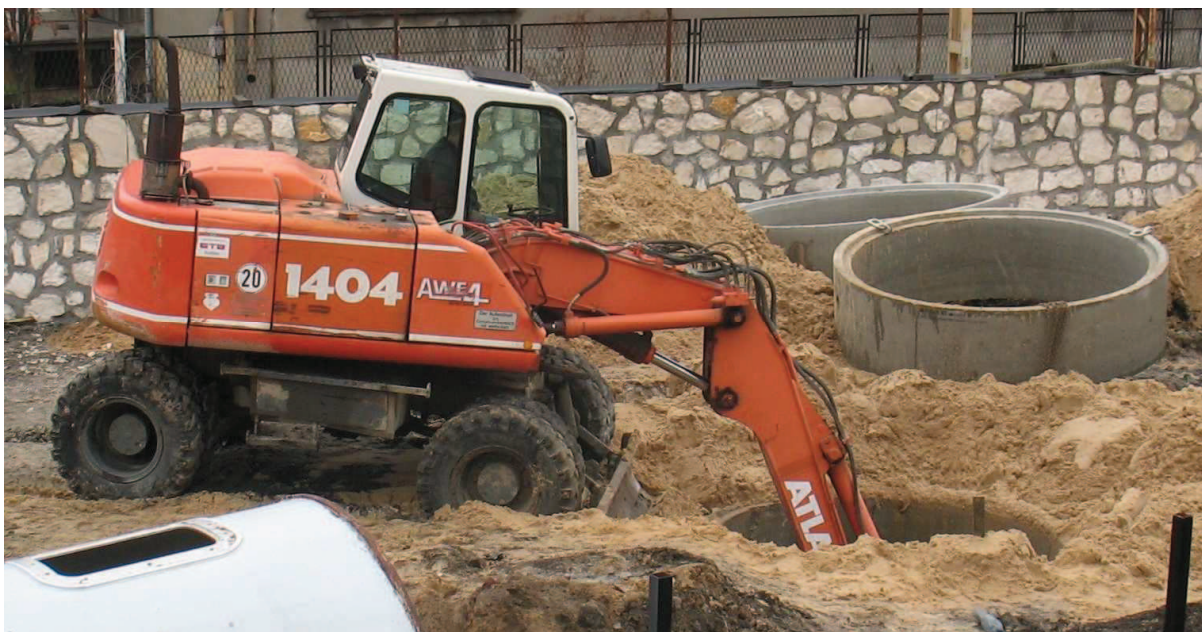
Fot. 5. Wykop pod fundament (głębokość ponad 8 metrów, średnica prawie 3 metry).
