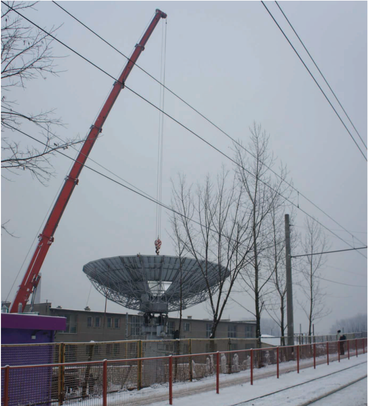
Fot 23. Czasza RT-13A wisząca na ramieniu dźwigu podczas operacji cumowania do nogi.
