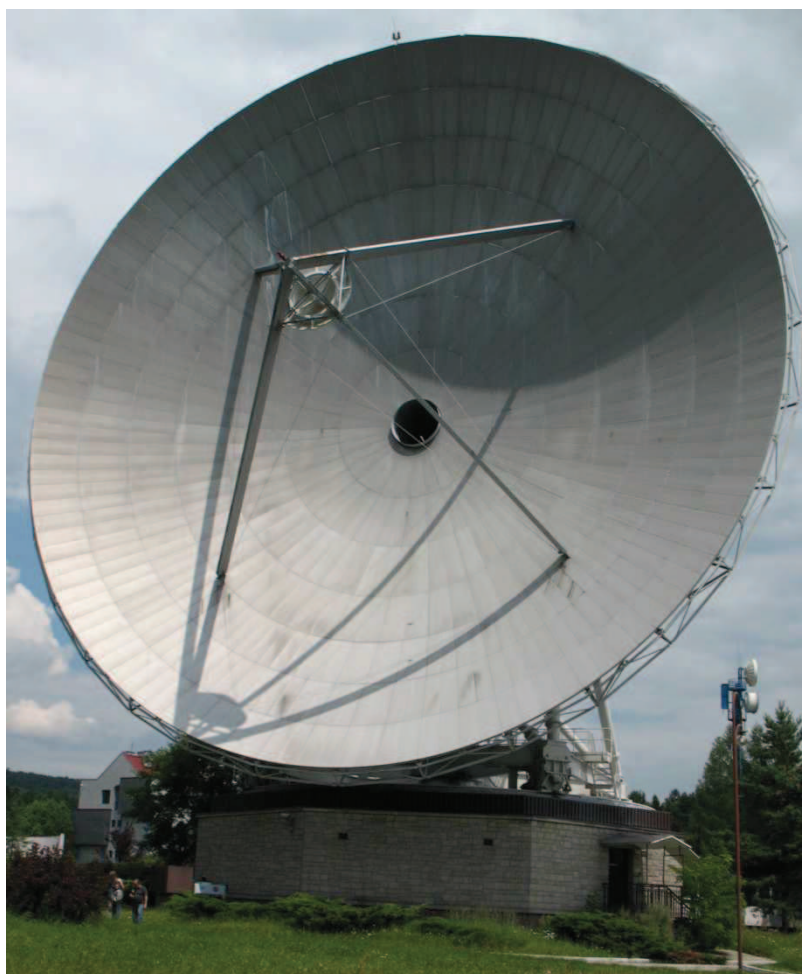
Fot. 1. Największy radioteleskop spośród zbudowanych kiedykolwiek w Polsce. Do roku 2010 pracował w Psarach k. Kielc. Jako doskonale sprawny został zniszczony ze względów politycznych. Średnica czaszy radioteleskopu wynosiła 32.5 metra.
