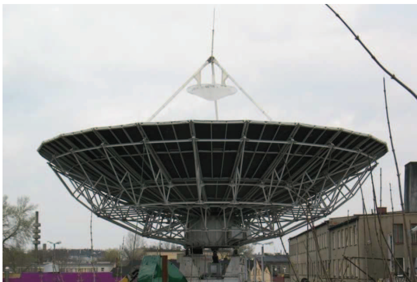
Fot. 28. Wygląd czaszy RT-13A po zainstalowaniu zwierciadła wtórnego.
