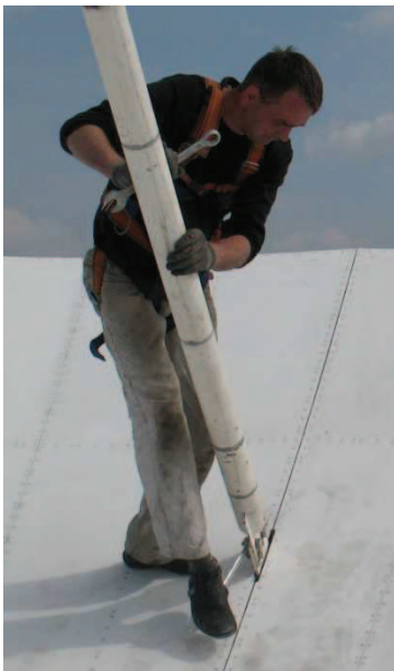
Fot. 27. Mariusz Frączyk i autor podczas montażu zwierciadła wtórnego przy RT-13A.
