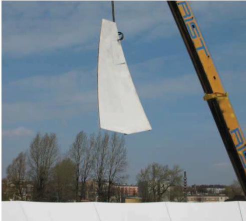
Fot. 26. Uzupelnianie brakujących paneli we wcześniejszym poszyciu czaszy. Mariusz Frączyk w akcji montażu panelu z otworem włazu.
