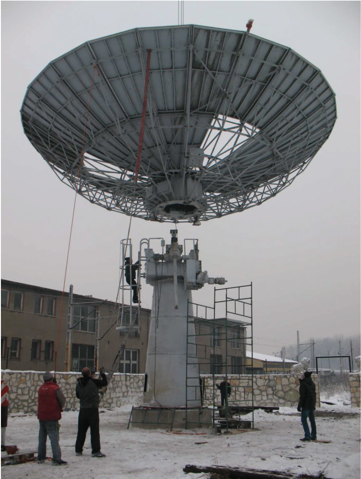
Fot. 21. Skomplikowany manewr cumowania czaszy. Wisi ona na wysuniętym na maksimum ramieniu dźwigu i istnieje obawa, że cumowania nie da się w ogóle zrealizować. Uchwycono moment, kiedy autor wychodzi na szczyt nogi dla precyzyjnego naprowadzenia uchwytów czaszy na uchwyty nogi.
