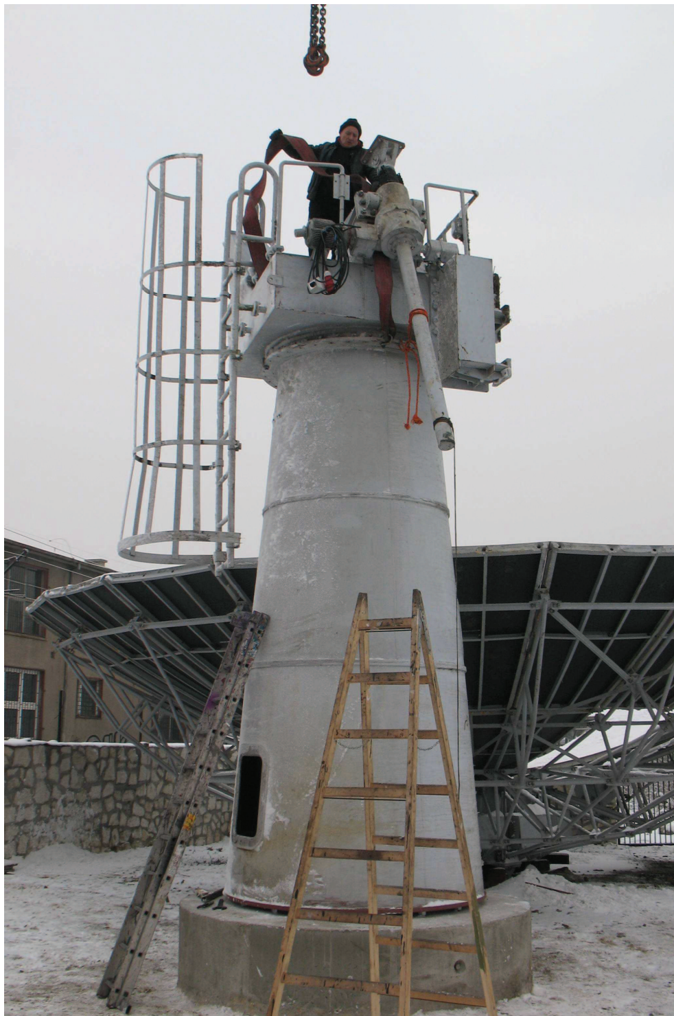
Fot. 15. Moment uwalniania nogi radioteleskopu od haków dźwigu.
