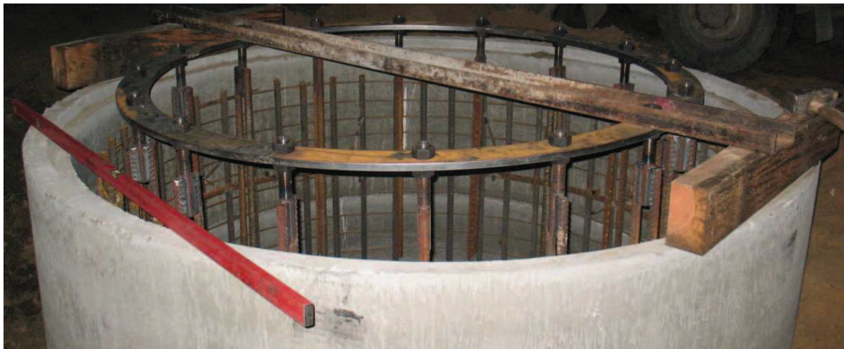
Fot.6. Zbrojenie fundamentu i wyprowadzenie szesnastu śrub mocujących nogę anteny.
