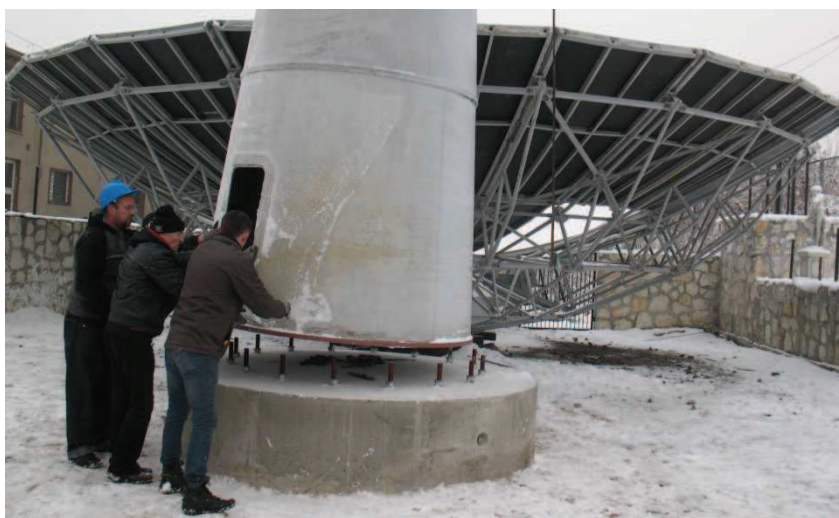
Fot. 14. Montaż nogi radioteleskopu na fundamencie. W akcji Marek Orlikowski, Przemysław Wosek i autor (10 grudnia, 2012).
