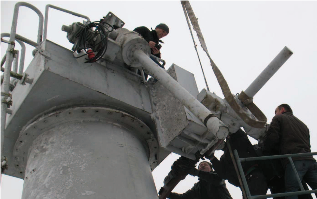
Fot. 16. Montaż siłownika poziomego.
