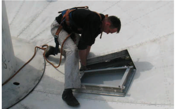
Fot. 26. Uzupelnianie brakujących paneli we wcześniejszym poszyciu czaszy. Mariusz Frączyk w akcji montażu panelu z otworem włazu.
